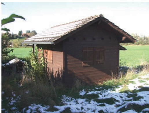
Bâtiment construit par les chalets Tardy
